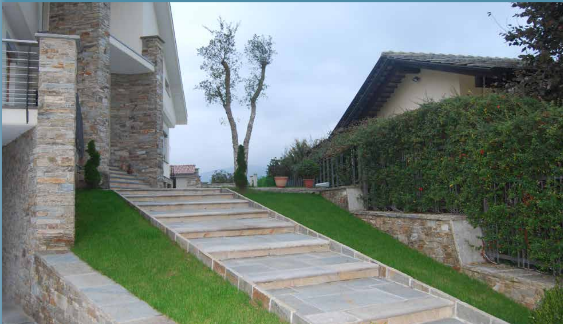
PAVIMENTO PIANO NATURALE, lati martellati grigio misto > Dalles plan naturel, bords épaufrés gris-vert > Bodenplatten OF bruchrau, Kanten handbekantet grau gemischt > Tiles natural plane, handcut, grey mixed
